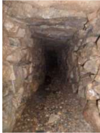
Murs en bon état, constitués de gros blocs de granit empilés sans liant couverts de larges dalles
