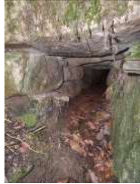
... Conduit, très bien conservé, pour la sortie de l'eau (h= 60 ; l =40 ; profondeur= 150 cm) ...
